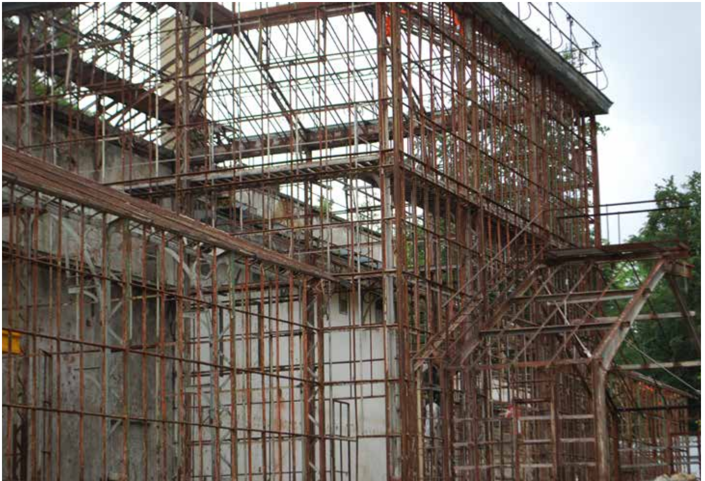
Nach dem Entfernen der schwer beschädigten historischen Verglasung, Foto: Stadlober
