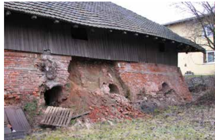
Oben: Zustand des baufälligen Ringofens 2007, links: nach der Sanierung
