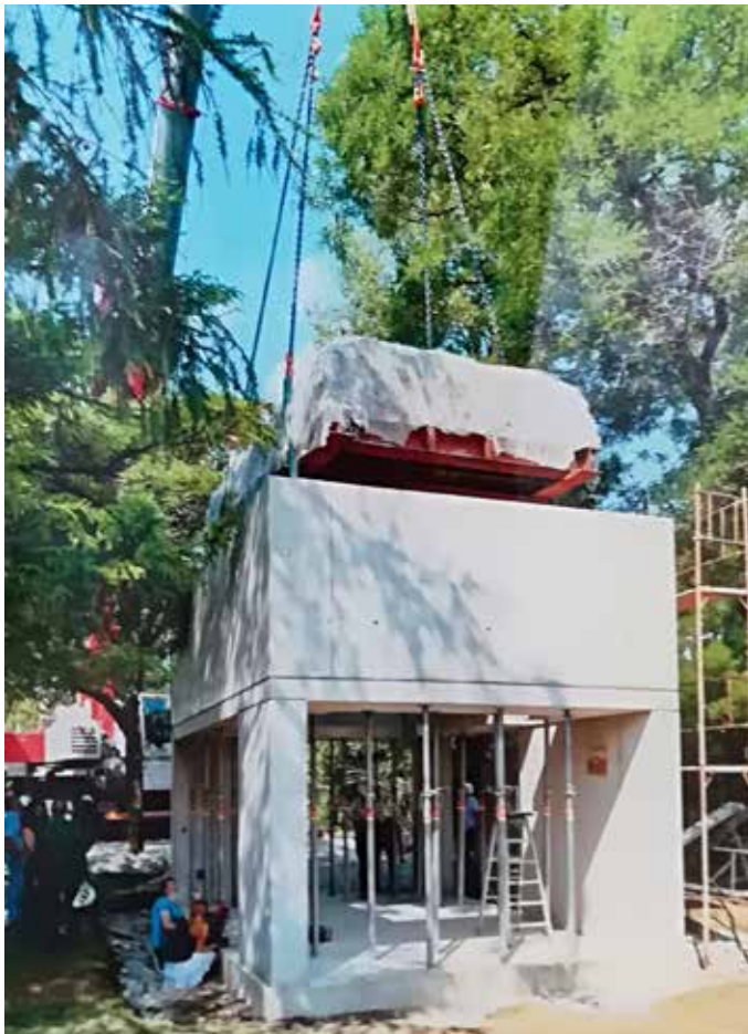
Die translozierte barocke Stuckdecke wird in einem Stück vom Kran auf den neuen Schulpavillon gehoben.
