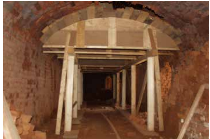
Sanierung der Gewölbe: oben desolater Gewölbescheitel am Brennkanaal und nach dem Abbruch unten: Lehrgerüst, Neuerschaltung und Remonade
