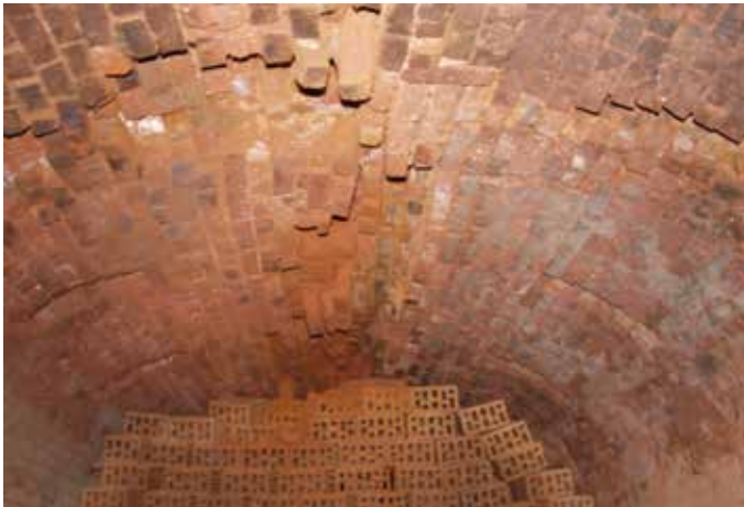
Sanierung der Gewölbe: oben desolater Gewölbescheitel am Brennkanaal und nach dem Abbruch unten: Lehrgerüst, Neuerschaltung und Remonade
