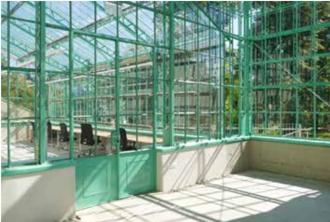
Restauriertes Gewächshaus mit originale Anstrich und moderner Verglasung
