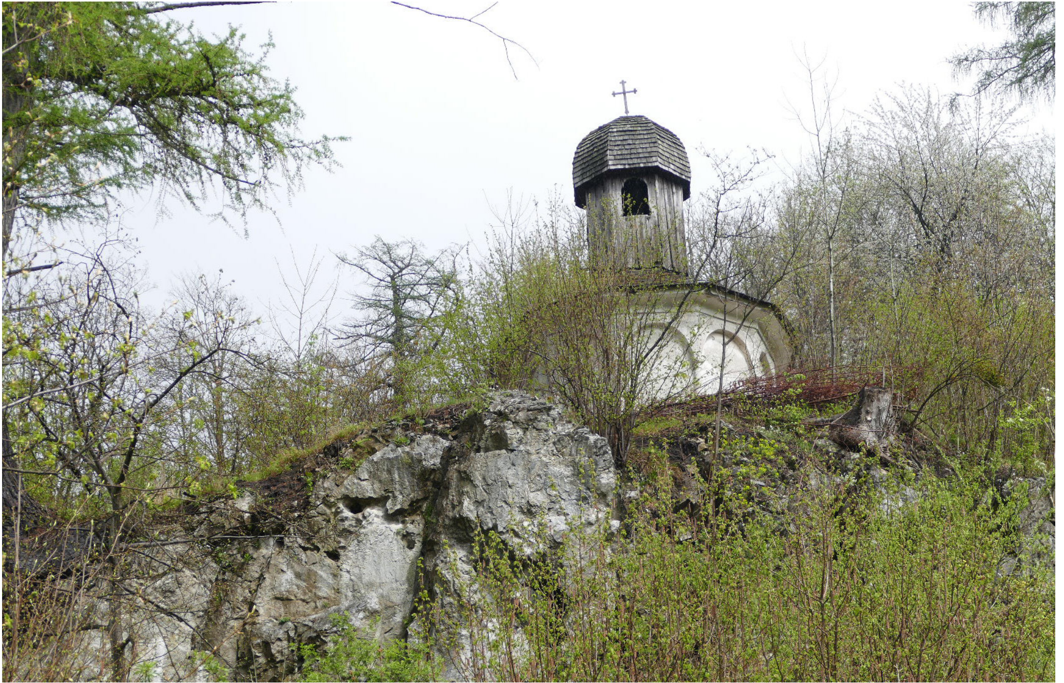
Sanierungsprojekt Kalvarienberg Mautern
