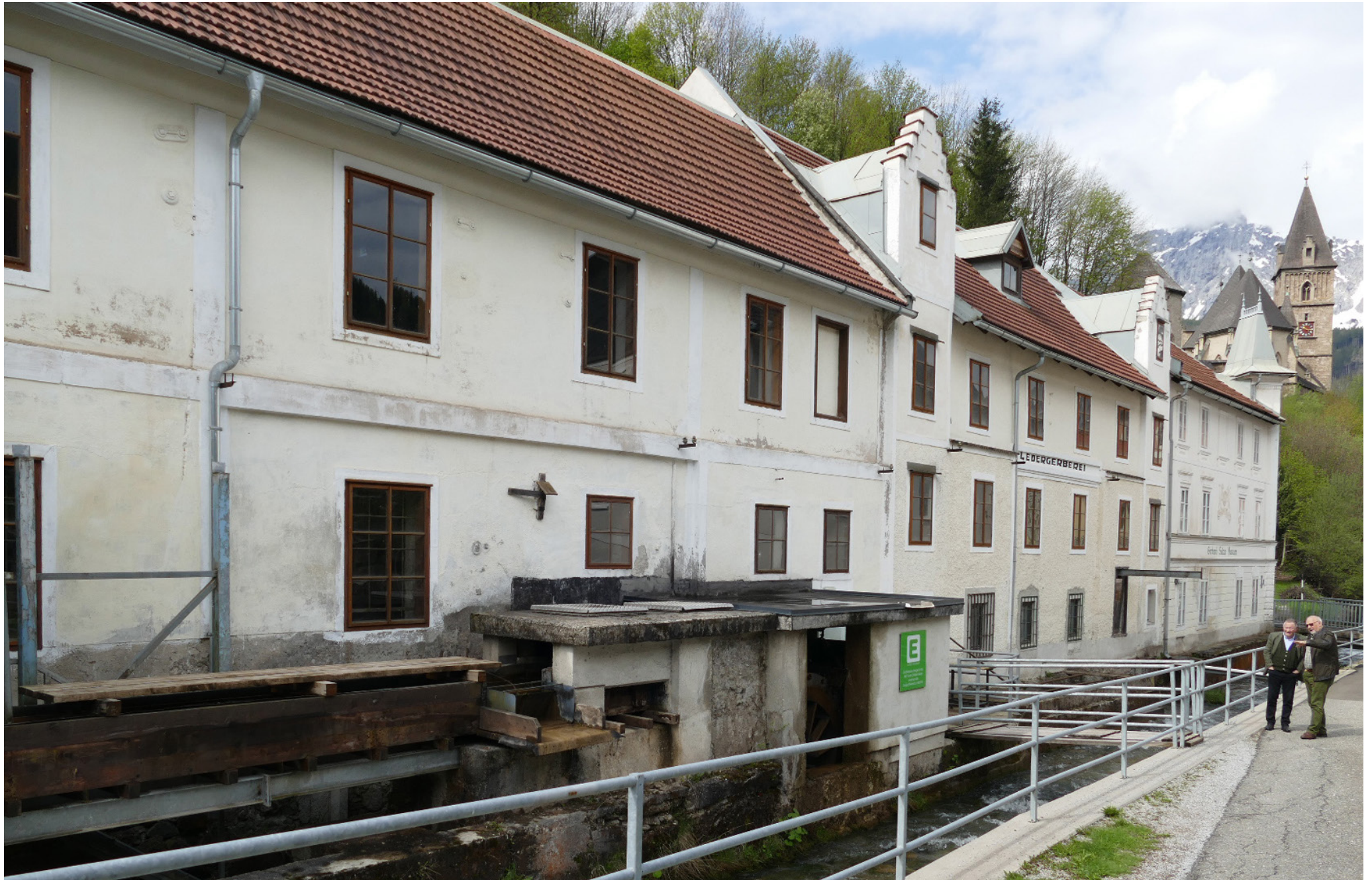
Der Gebäudekomplex der ehemaligen Gerberei Salzer nach der 2019 abgeschlossenen Revitalisierung
